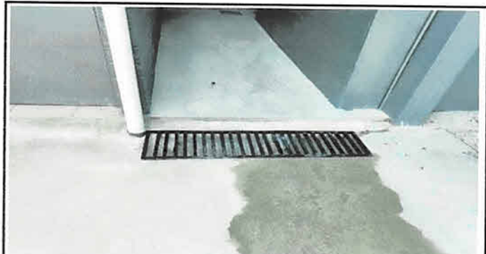
Foto 4: Reparacion del drenaje e instalacion de rejilla
