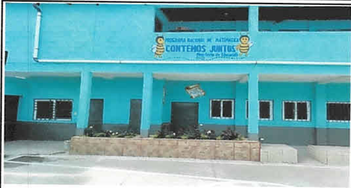
Foto7: Pintura de paredes interior terminado, jardinera terminada, ventanas pvc terminadas, puertas terminadas
