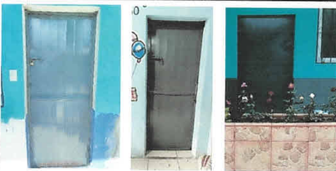
Foto 5: Puertas Terminadas de instalar
