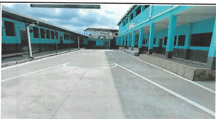
Foto 9: Canales y bajadas de agua terminados, pintura de cancha, mesa de arena terminada, pintura interior de la escuela terminada
