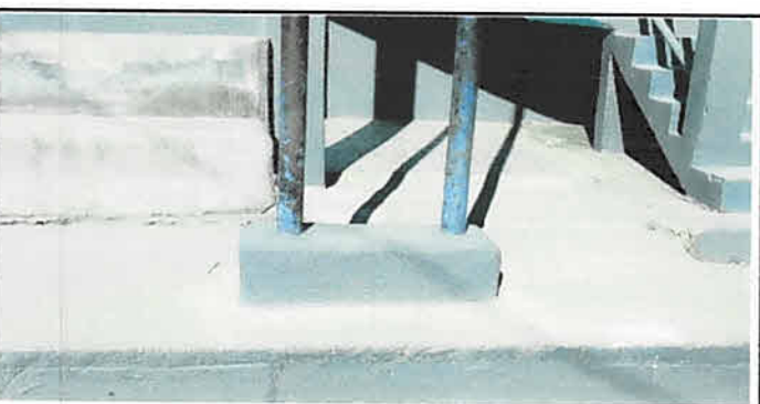
Foto 11: Base de astas de banderas reparada y terminada
