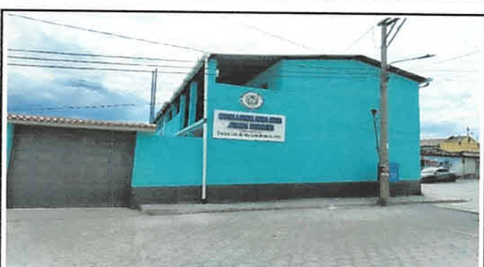
Foto 10: Rotulo identificacion del establecimiento terminado, pintura exterior, bajada de agua, cambio de teja al techo del porton, pintura exterior
