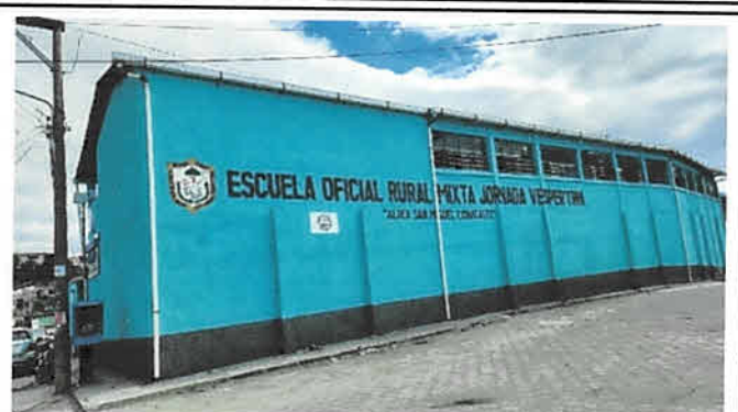
Foto 2: Paredes ya repelladas, pintadas, canales terminados, bajadas de los canales terminados, escuela identificada
