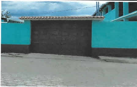
Foto 3: Porton con puerta incrustada, pintura de exterior, cambio de teja del techo del porton
