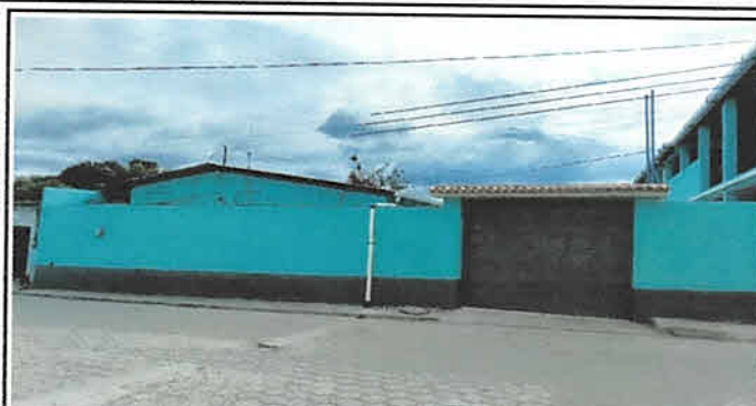
Foto 8: Pintura de paredes exterior terminado, porton terminado, bajada de agua terminada, teja del techo del porton cambiada y terminada
