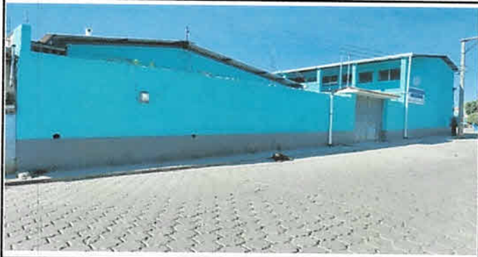
Foto1: Repello, pintura y rotulo identificacion del establecimiento
