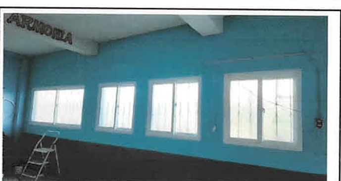
Foto 12: Ventanas pvc instaladas y terminadas
